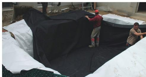
2. Déploiement de la géomembrane EPDM 3D
