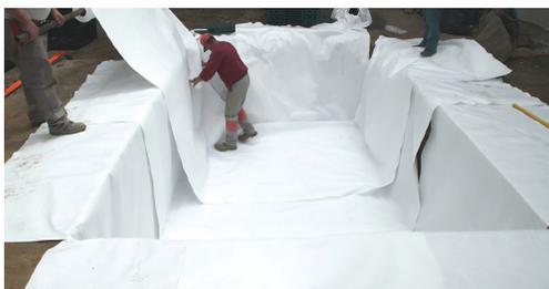
1. Pose du géotextile de protection intérieur
